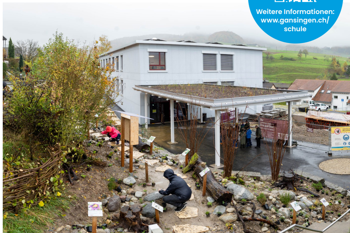
Abwechselnd hilft ein Teil der Kinder beim Bau des Wildbienenparadieses und bekommt von «Wildbienenflüsterer» Yannick Schauwecker (unter der Überdachung) im Lerngespräch viele Infos.
